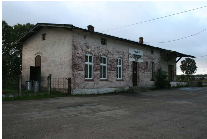
Rysunek 5. Stacja kolejowa w Łubowie
