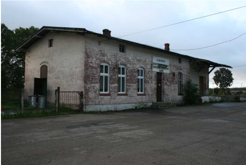
Rysunek 5. Stacja kolejowa w Łubowie
