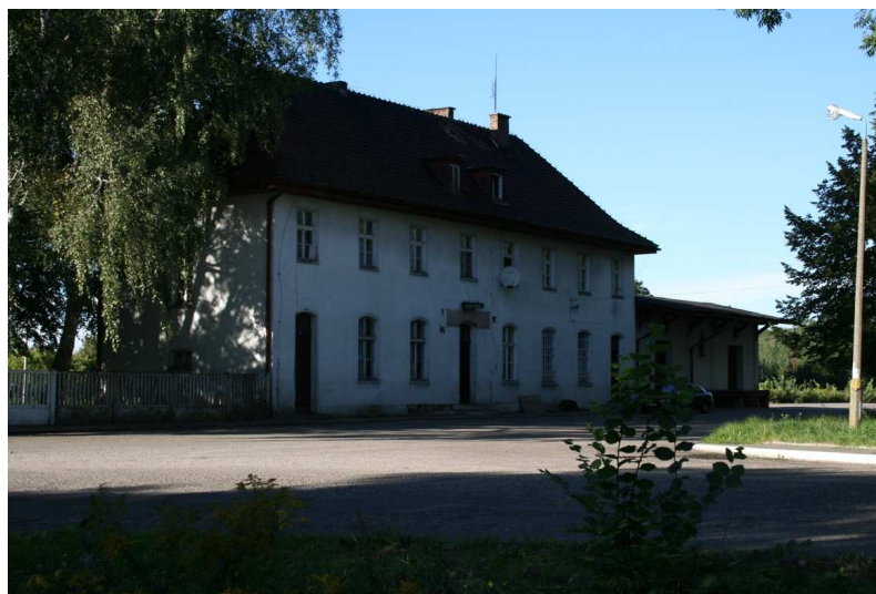
Rysunek 6. Stacja kolejowa w Silnowie – budynek z 1935 roku.
