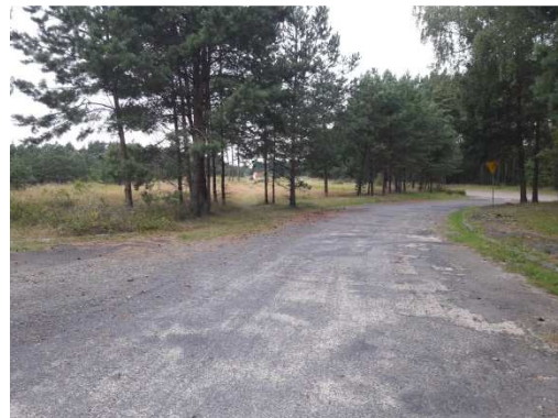
Fot. 6 ul. Kolejowa
