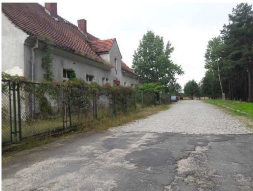
Fot. 5 ul. Kolejowa
