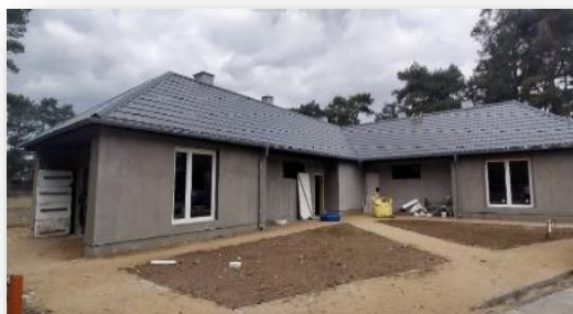
Zdjęcie 7. Budowa przystani kajakowej w Bornem Sulinowie
