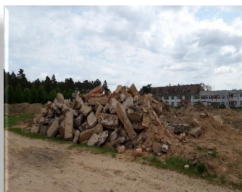
W trakcie inwestycji
