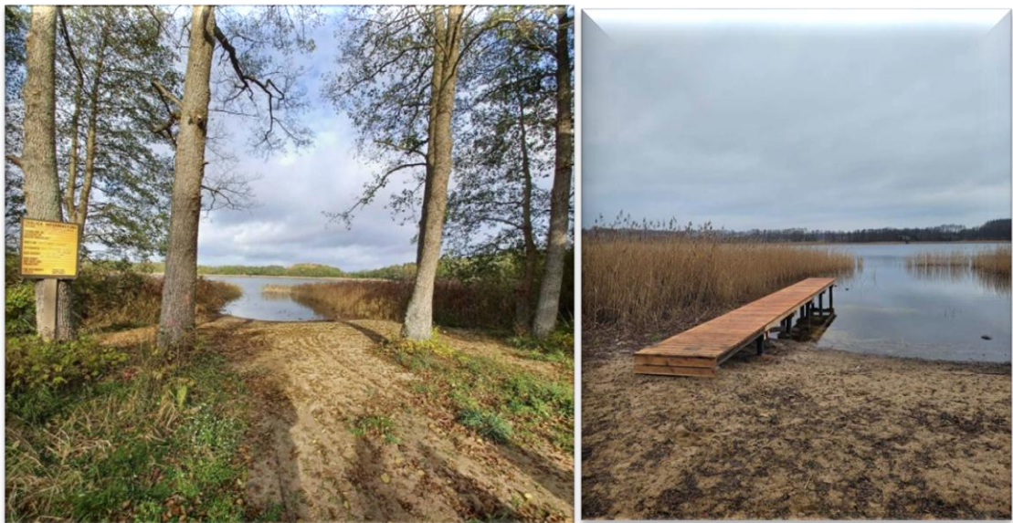
Zdjęcie 24. I etap budowy pomostu w miejscowości Jeleń
