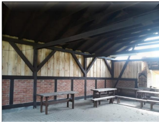
Zdjęcie 33. Odeskowanie ścian w wiacie rekreacyjnej w miejscowości Łączno
