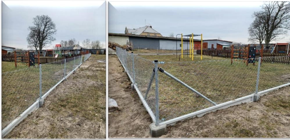
Zdjęcie 43. Ogrodzenie placu gminnego w miejscowości Uniemino
