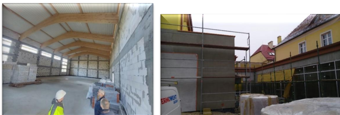
Zdjęcie 15. Sala gimnastyczna przy szkole podstawowej w Łubowie w trakcie budowy
