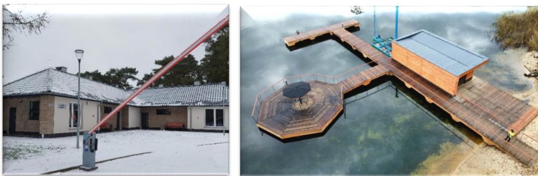
Zdjęcie 3. Budowa przystani kajakowej w Bornem Sulinowie
