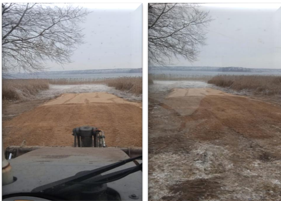
Zdjęcie 36. I etap budowy slipu w miejscowości Piława - roboty przygotowawcze.
