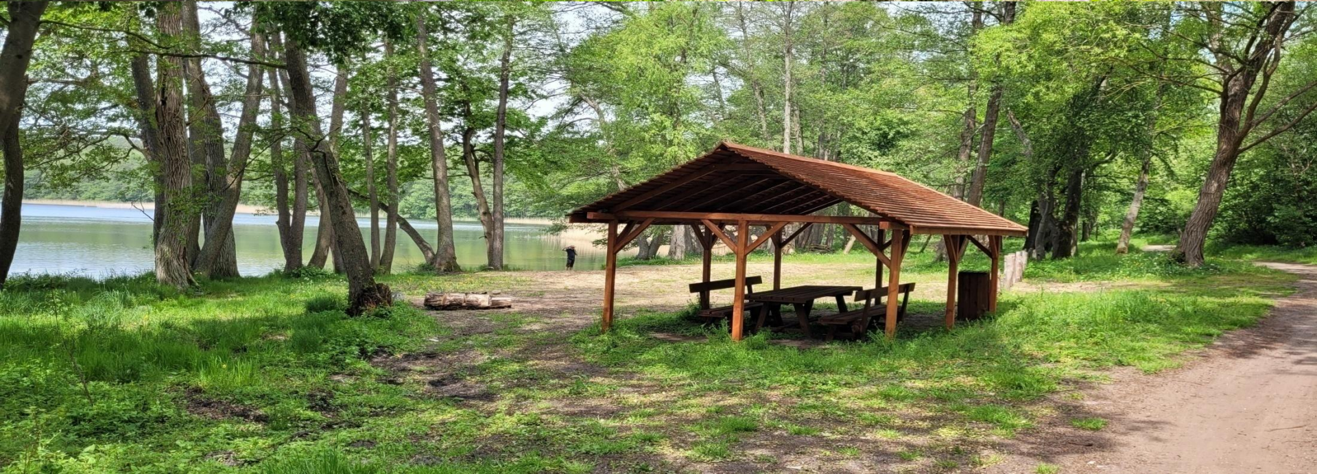
Kładka rowerowa i wiata na terenie sportowo - rekreacyjnym w Kragach
