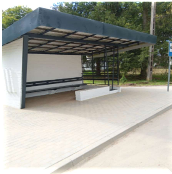
Zdjęcie 25. Remont przystanku w Silnowie (po zakończeniu inwestycji)
