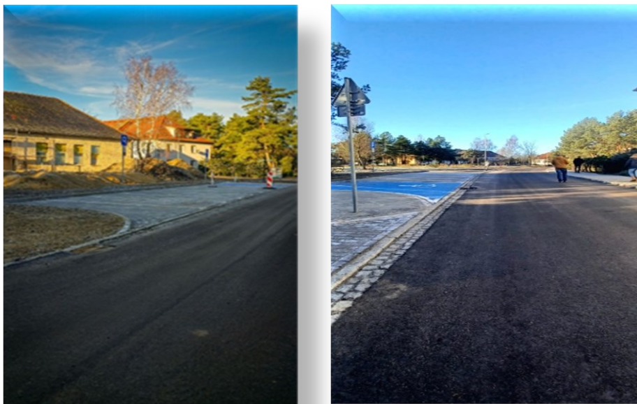
Zdjęcie 5. Zmodernizowana ul. M. Konopnickiej w Bornem Sulinowie
