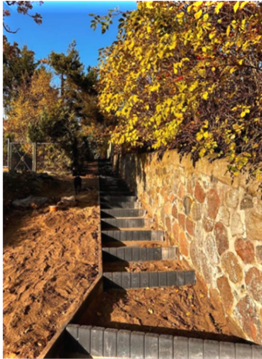
Zdjęcie 23. Zmodernizowane zejście na plażę
