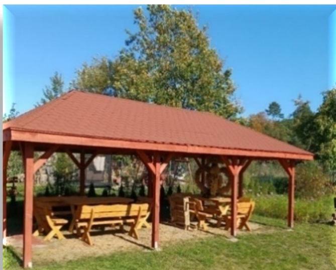
Zdjęcie 20. Utwardzenie terenu kostką brukową o powierzchni ok. 40 m 2 pod istniejącą altaną rekreacyjną w m. Juchowo
