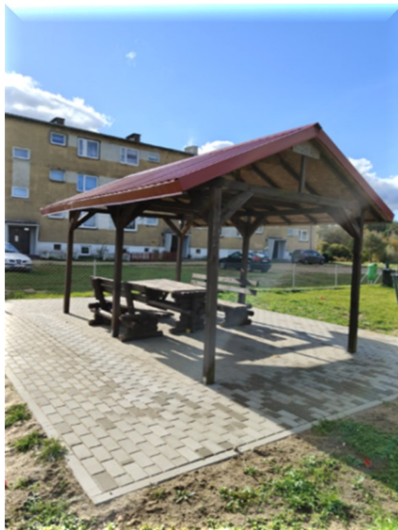
Zdjęcie 27. Utwardzenie terenu pod altanę rekreacyjną w Unieminie
