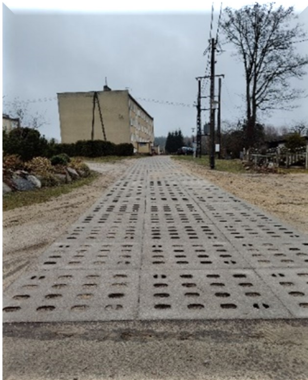
Zdjęcie 18. Utwardzenie terenu z płyt JOMB przed i po zakończeniu inwestycji
