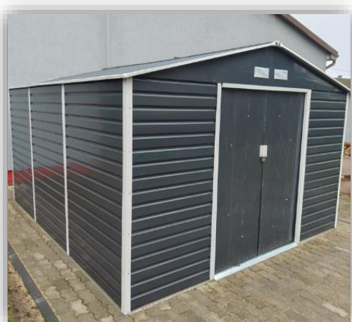
Zdjęcie 51. Utwardzenie terenu kostką brukową oraz montaż domku narzędziowego
